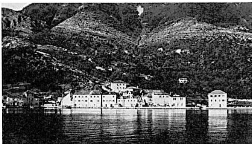
Graditeljska cjelina priobalnog naselja Kamenari, početak XX vijeka
