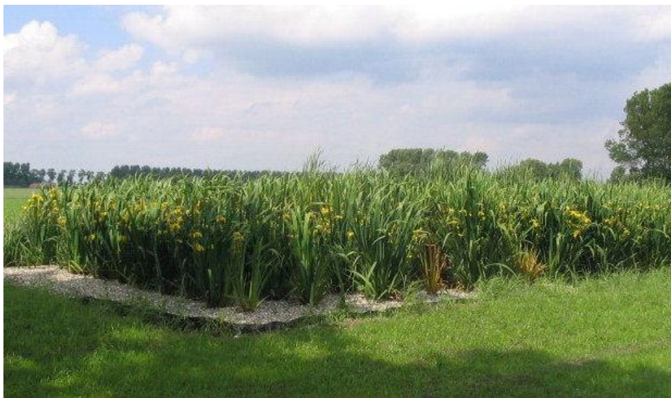
Slika : Izgled biljnog uređaja za prečišćavanje otpadnih voda, Prud, Hrvatska
