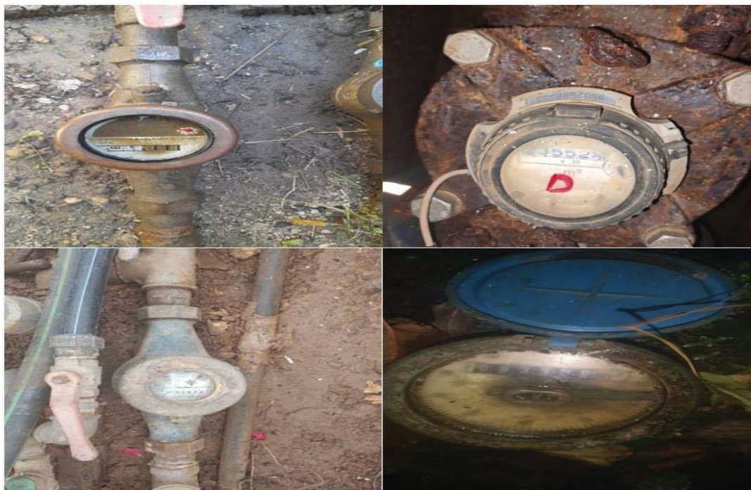
Realan prikaz stanja mjernih mjesta i dotrajalosti vodomjera
