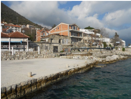
Slika: Izgrađena obala
