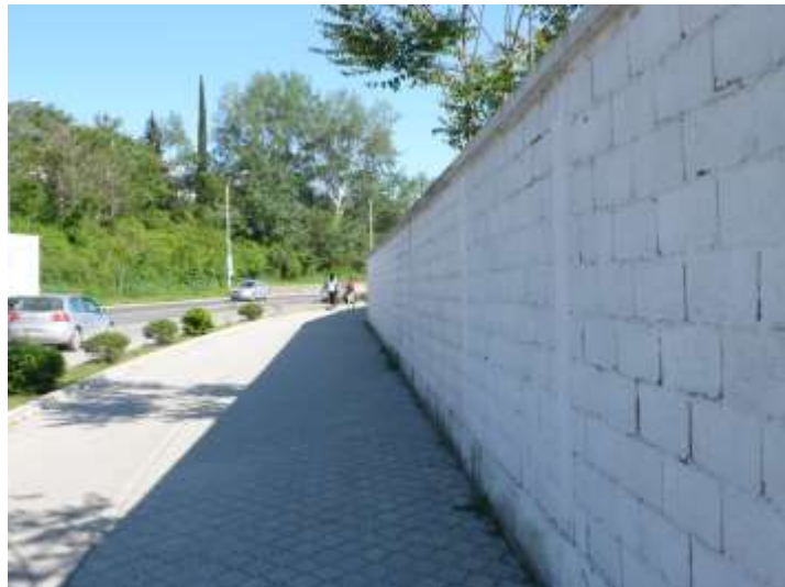
Slika 1.7. Ogradni zid kompleksa
