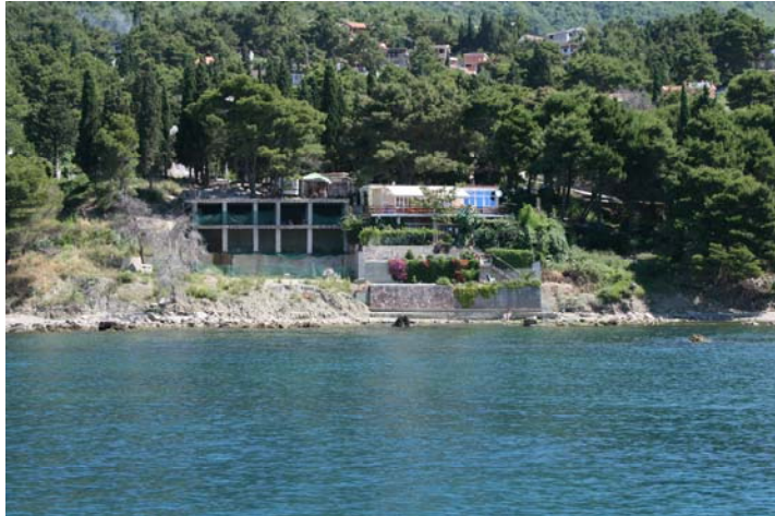
Sl. 3. Izgradnja na obali
