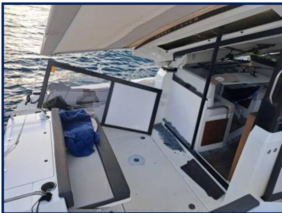
Slika 24. Oštećenje nadgradja motorne jahte MNE 0904
