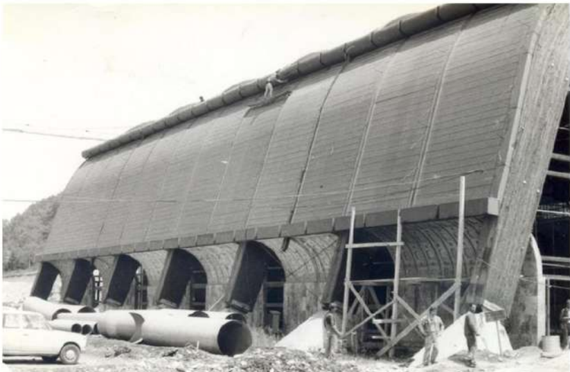
Izgradnja dvorane 1981 godine
