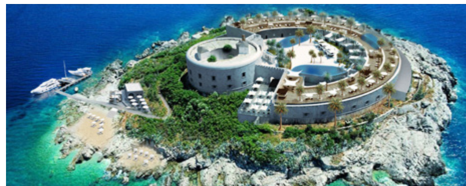
CGI BUDUĆEG DIZAJNA KOJI JE POSLUŽIO ISKLJUČIVO KAO PRELIMINARAN IZLED KAKO BI ORASCOM NA TENDERU POKAZAO KONCEPT KOJI PODRAZUMIJEVA DA ĆE TVRĐAVA BITI SAČUVANA U MAKSIMALNO MOGUĆOJ MJERI
