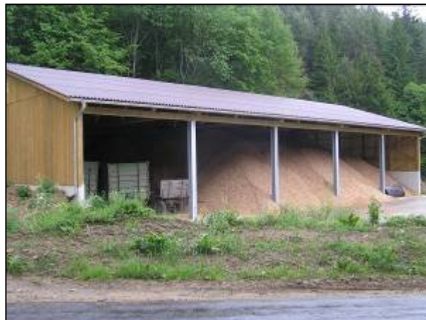
Slika 22. Poluzatvoreno skladište drvene sečke (Warth, Austrija, jun 2007. Foto: B. Glavonjić)
