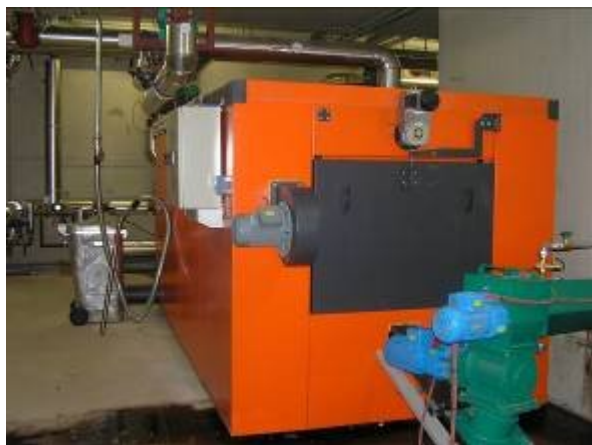
Slika 23. Unutrašnjost toplane na drvenu sečku (levo) i spiralni transporter za dopremanje sečke iz skladišta do kotla (desno)(toplana u Winerneustadtu, Austrija, 2007. Foto:B. Glavonjić)
