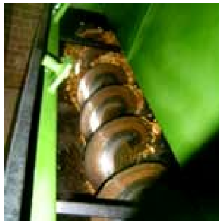
Slika 23. Unutrašnjost toplane na drvenu sečku (levo) i spiralni transporter za dopremanje sečke iz skladišta do kotla (desno)(toplana u Winerneustadtu, Austrija, 2007. Foto:B. Glavonjić)
