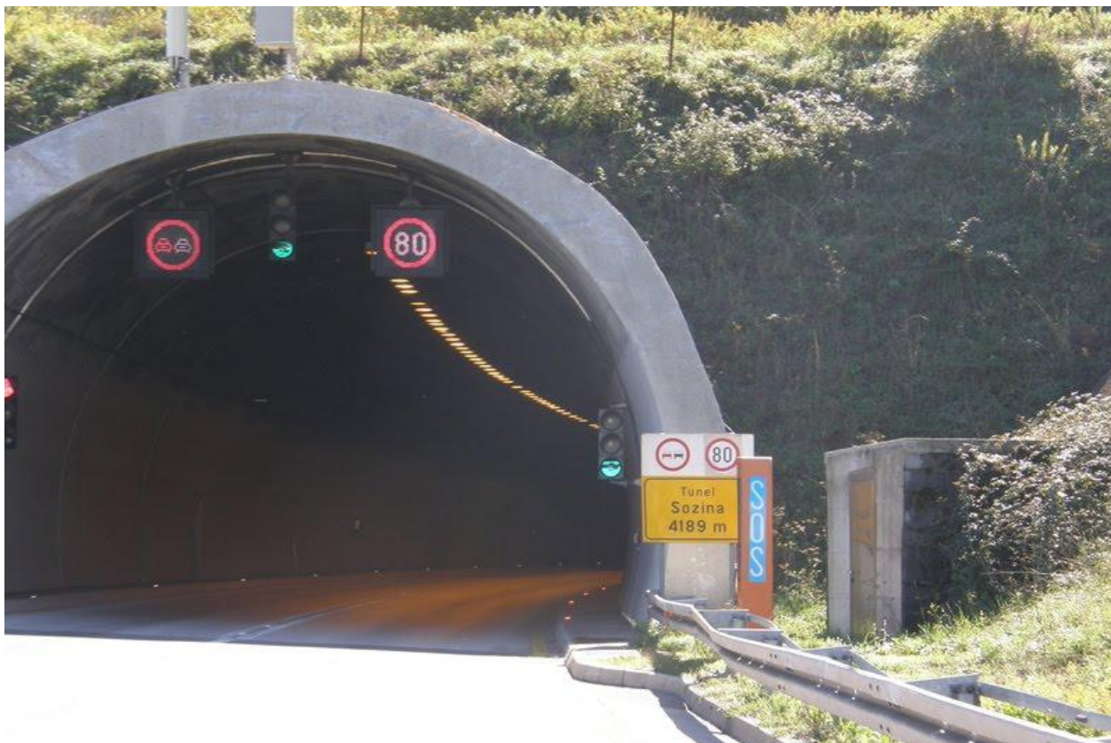
Slika 3.5: Oprema ITS postavljena u tunelu Sozina
