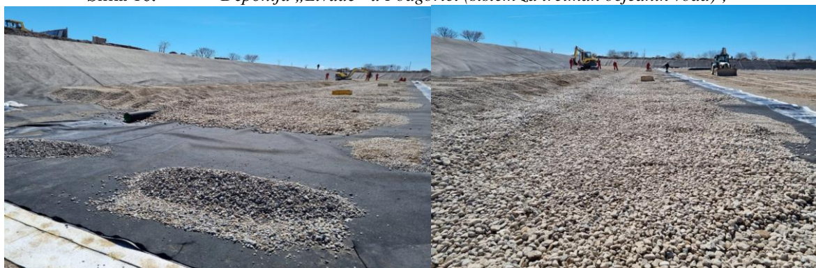
Slika 17. Deponija „Livade“ u Podgorici (radovi na izgradnji sanitarne kade 4)
