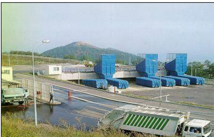
Slika 2: Automatska transfer stanica
