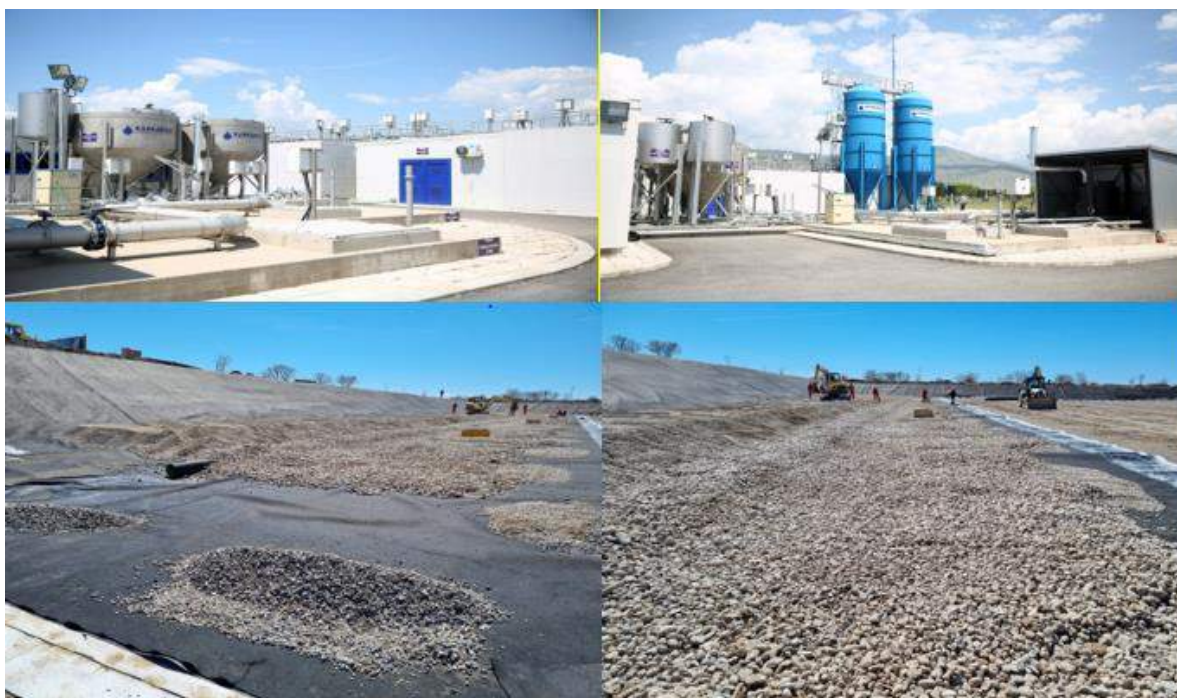
Slika 3. Deponija „Livade“ u Podgorici (sistem za tretman ocjednih voda) 2 , Deponija „Livade“ u Podgorici (tekući radovi na izgradnji sanitarne kade 4)
