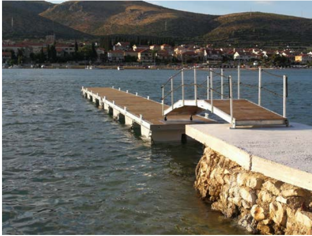
Planirani model plutajuće platforme za privez i pristajanje plovnih objekata
