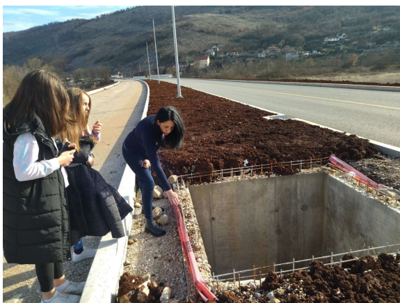
Pločasti propust sa otvorom za dodatnu svjetlost (foto: Danka Odalović)
