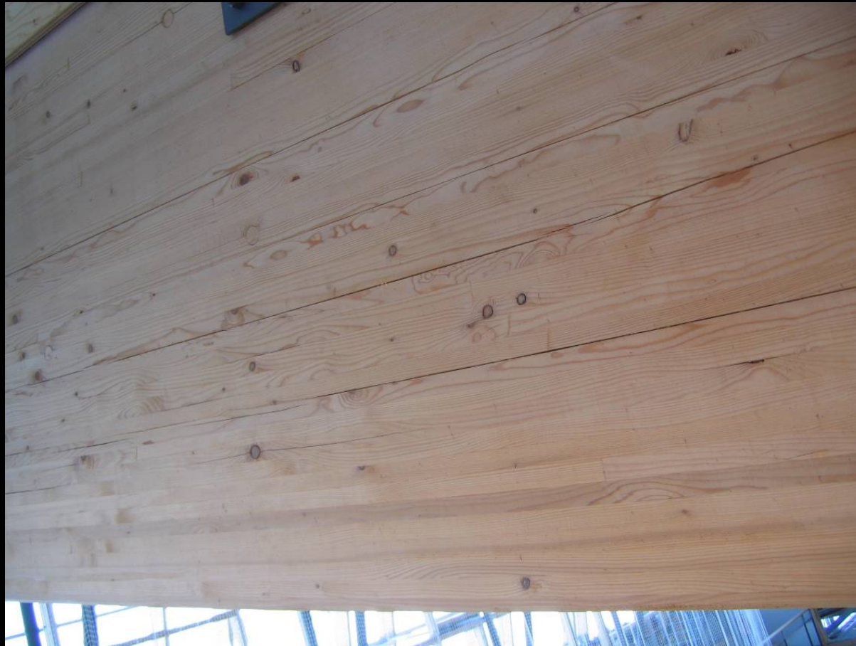
(Benediktbeuern, MPA BAU)
