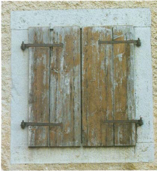
Zapuštena tradicionalna škura mogla bi još dugo trajati uz manje popravke i bojanje.
