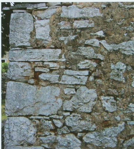
Ugao i struktura zida građenog iz grubo obrađenih blokova u vapnenom mortu s dodatkom crljenice.
