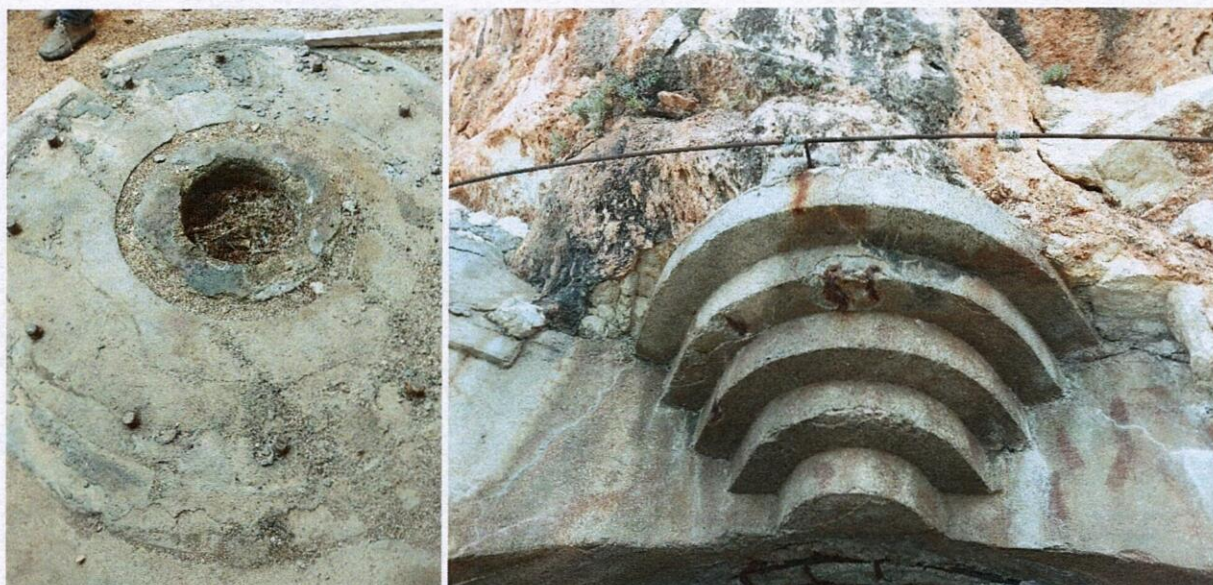
Ležište/postolje za top i čelična šina za zastor i istureni nadzidak obrnute stepenišne forme
