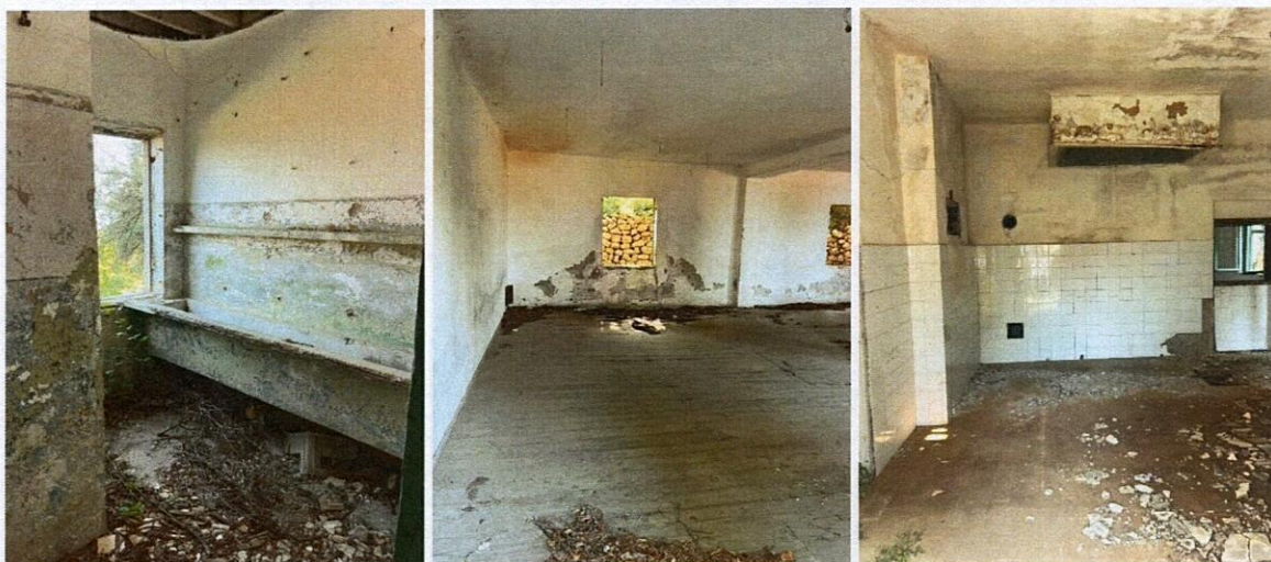
Kasarna – unutrašnjost objekata
