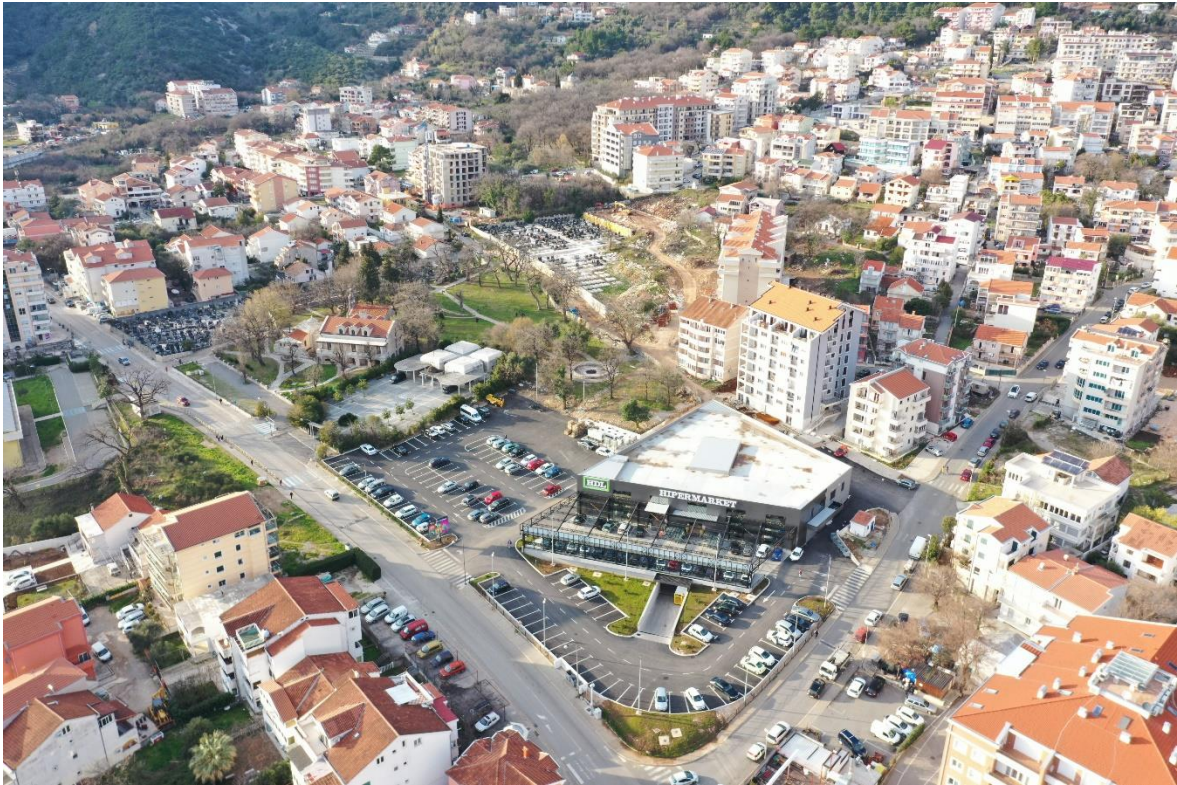
Slika 8: Blok 18 – postojeće stanje, snimak iz drona
