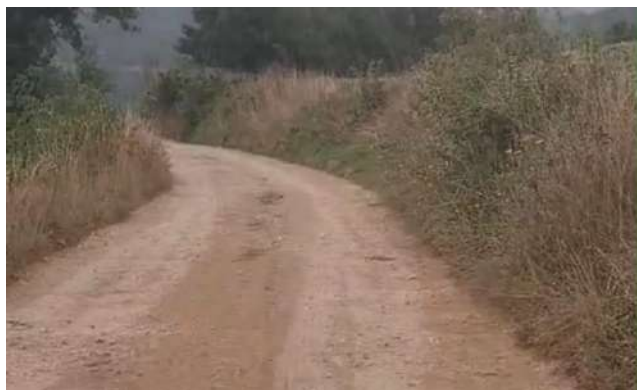
Fotografija 5. Put sa nevezanim zastorom
