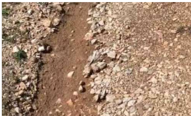
Fotografija 3. Erozijska brazda na kolovozu
