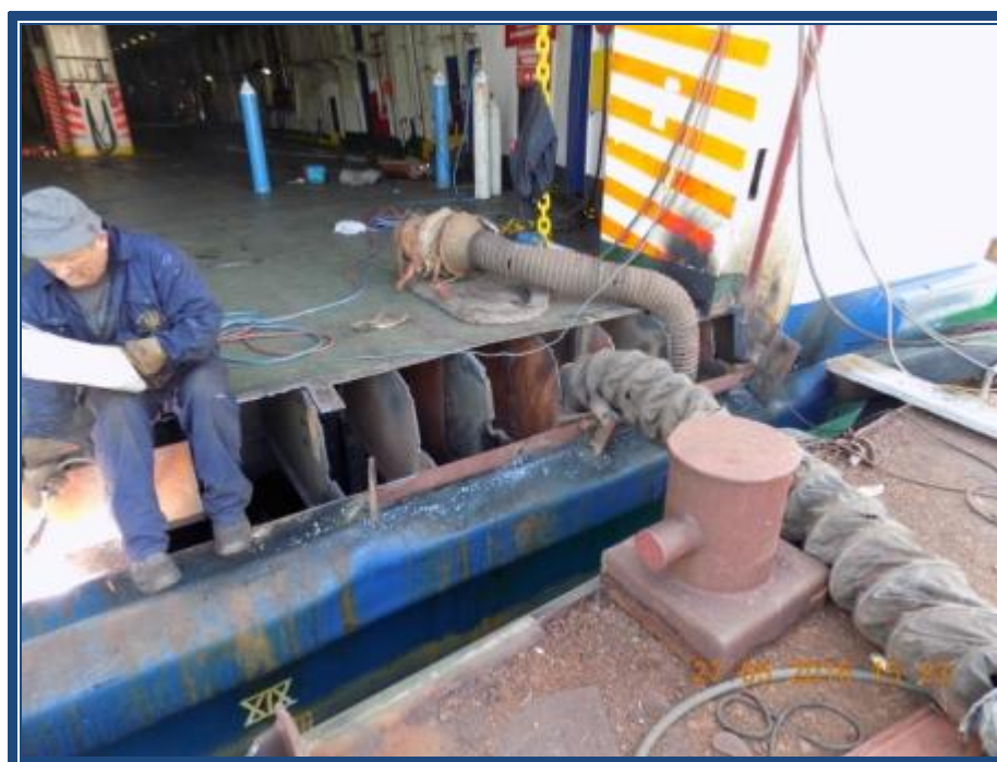
Slika 17. Ležište iskrcajno ukrcajne rampe
