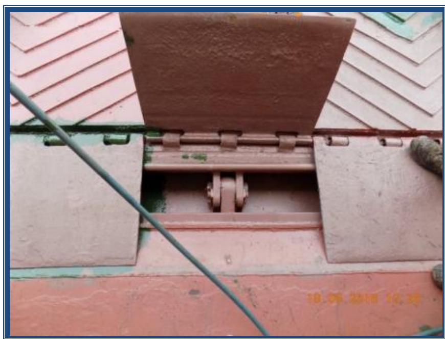
Slika 21. Remontovana iskrcajno ukrcajna rampa sa novim šarkama
