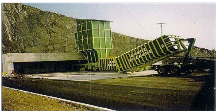
Slika 3: Uklanjanje kontejnera sa transfer stanice
