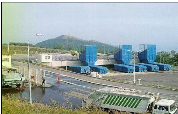
Slika 2: Automatska transfer stanica
