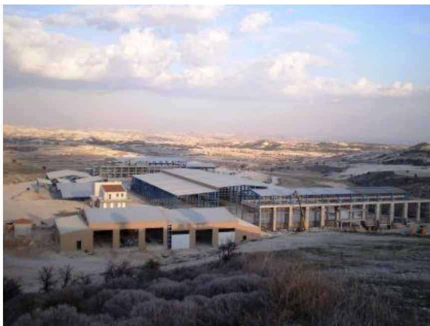
Larnaka – Ammohostos postrojenje za MBT (izvor: Helector Ltd, na: www.helector.gr )
