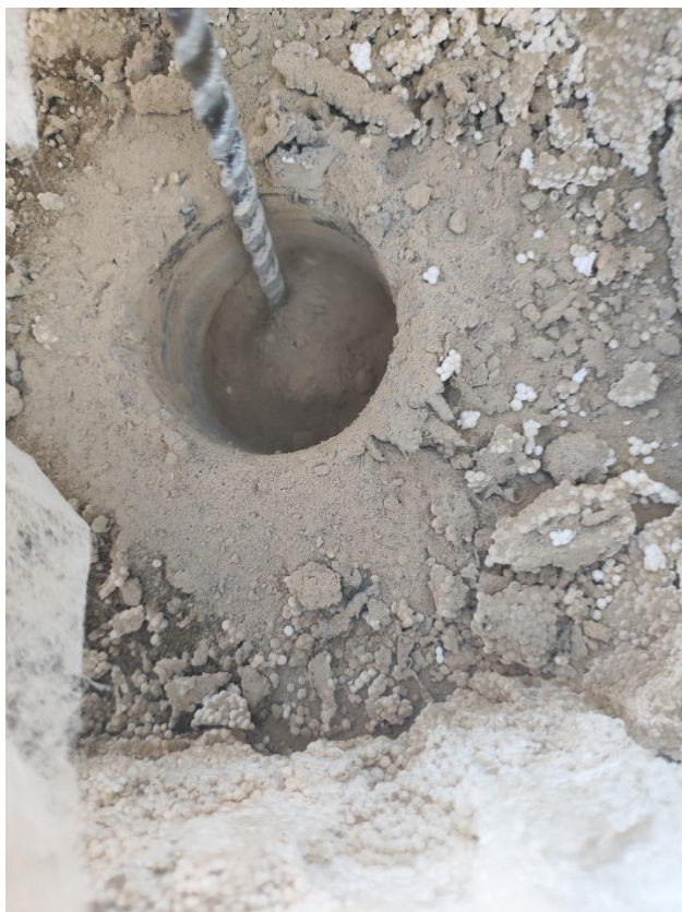
Sloj perlit betona ispod cementne košuljice
