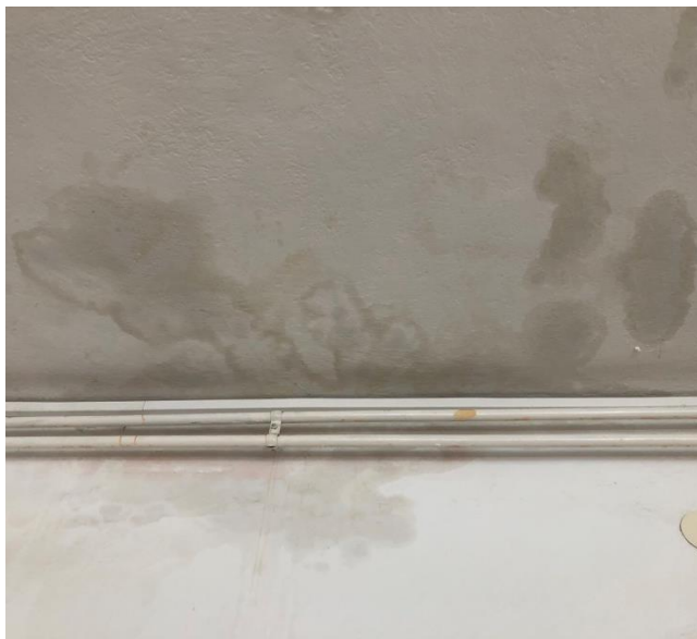
Vlaga od krova na plafoni i zidu
