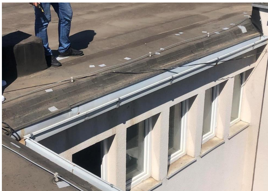
Izgled horizontalnih oluka 1 i 2 i završetak krovne membrane kod ovih oluka
