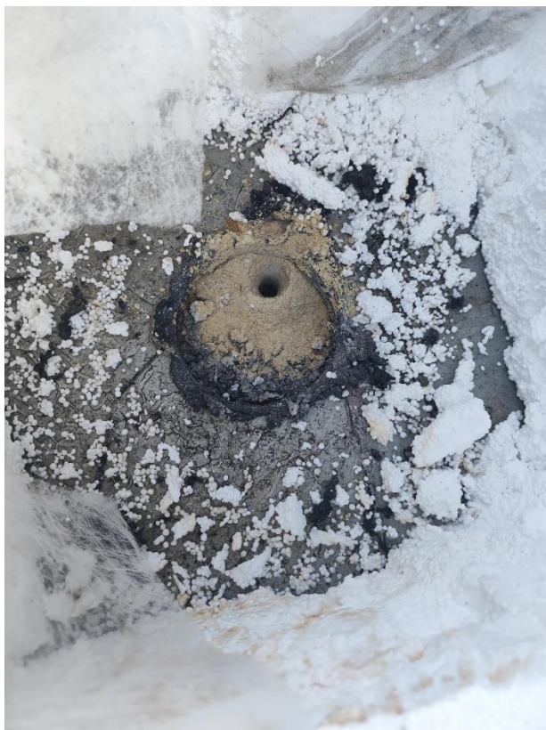
Izgled slojeva ispod krovne mebrane i polistirena d=10\text{cm} – Slojevi ravnog krova iz perioda izgradnje: mjerenje debljine postojeće bitumenske izolacije
