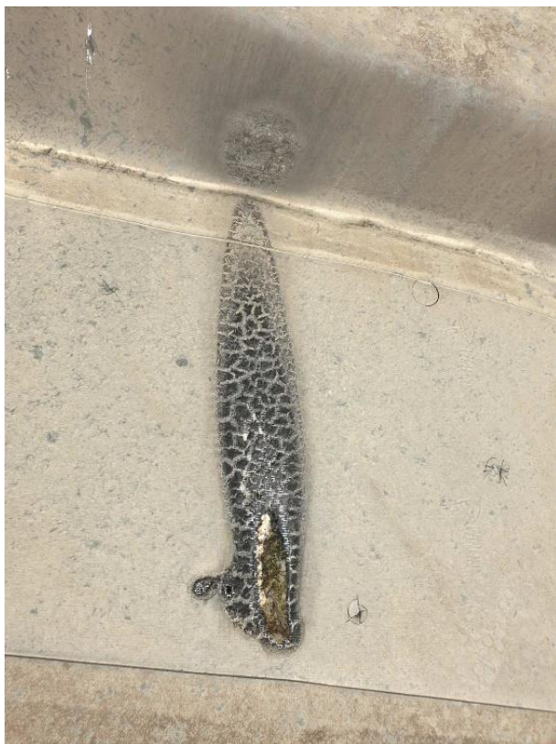
Vrste oštećenja na krovnoj foliji
