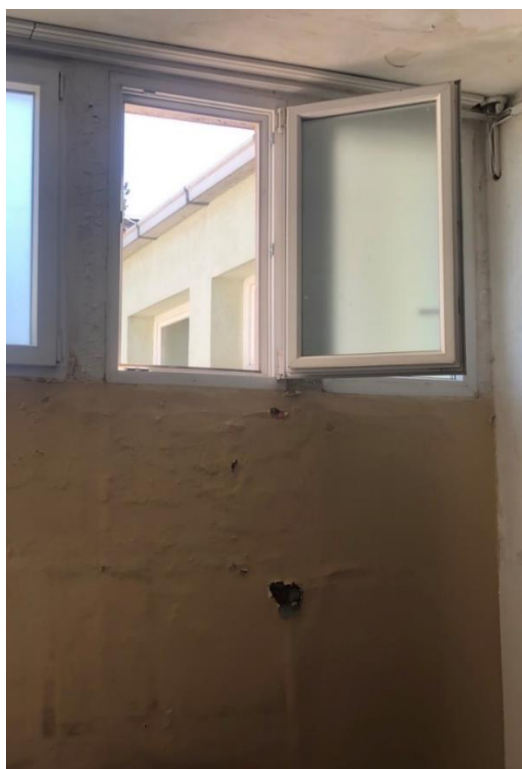
Vlaga na zidu ispod PVC stolarije
