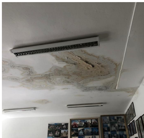
Vlaga od krova na plafoni i zidu
