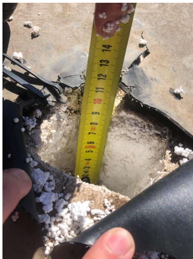
Izgled slojeva ispod krovne mebrane mjerenje debljine termičke izolacije
