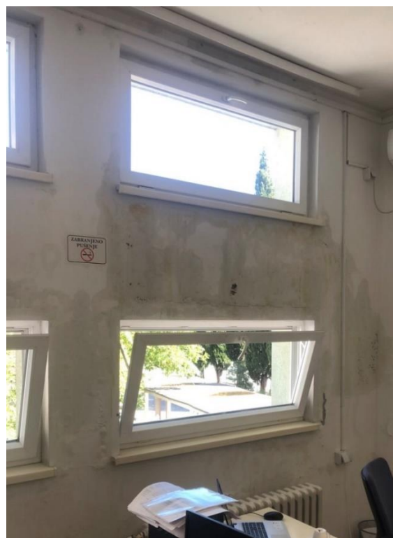
Vlaga na zidu ispod PVC stolarije
