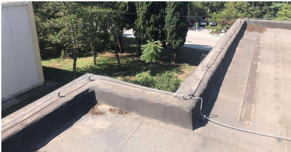
Izgled korvne atike opšivene krovnom membranom
