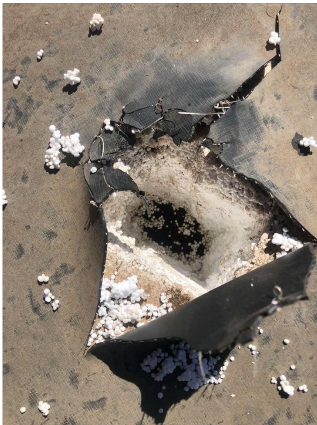
Izgled slojeva ispod krovne mebrane mjerenje debljine termičke izolacije
