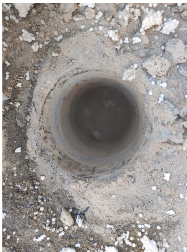
Sloj perlit betona ispod cementne košuljice
