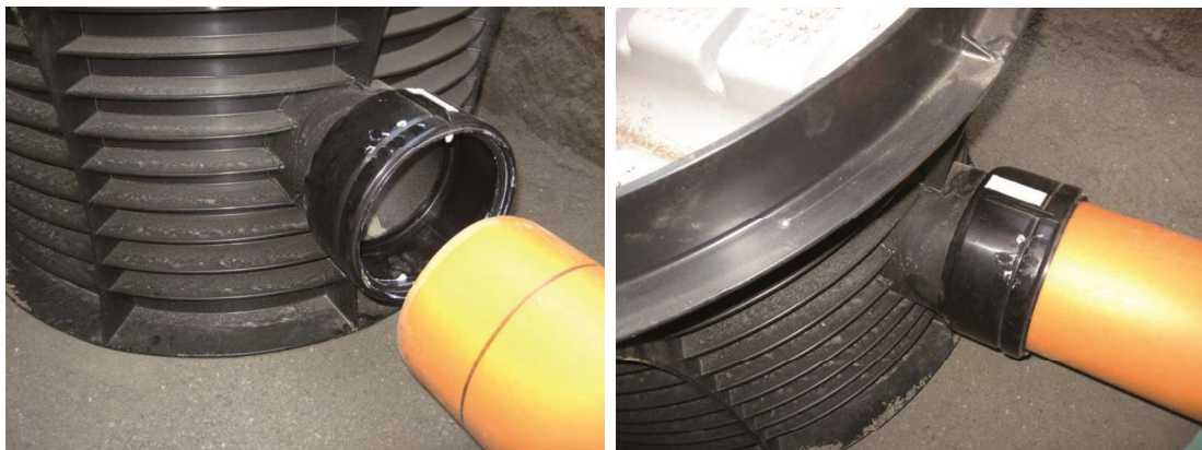
Slika 5 i 6: Izvođenje spoja šahta sa PVC cijevima
