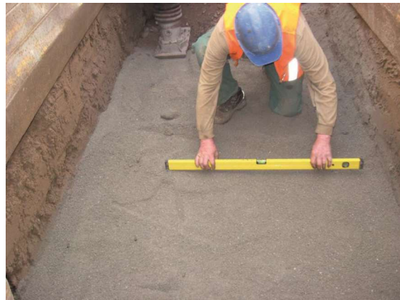
Slika 1 i 2: Priprema podloge za polaganje šahtova
