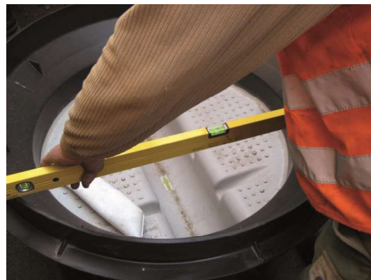
Slika 3 i 4: Kontrola položaja odvoda
