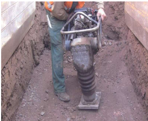
Slika 1 i 2: Priprema podloge za polaganje šahtova
