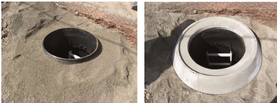
Slika 9 i 10: Postavljanje betonskog prstena za prihvatanje opterećenja
