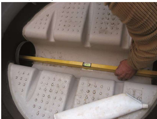
Slika 3 i 4: Kontrola položaja odvoda
