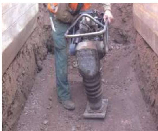
Slika 1 i 2: Priprema podloge za polaganje šahtova
