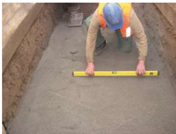
Slika 1 i 2: Priprema podloge za polaganje šahtova
