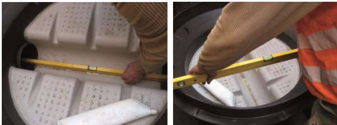
Slika 3 i 4: Kontrola položaja odvoda
