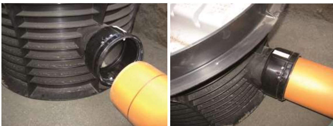
Slika 5 i 6: Izvođenje spoja šahta sa PVC cijevima
