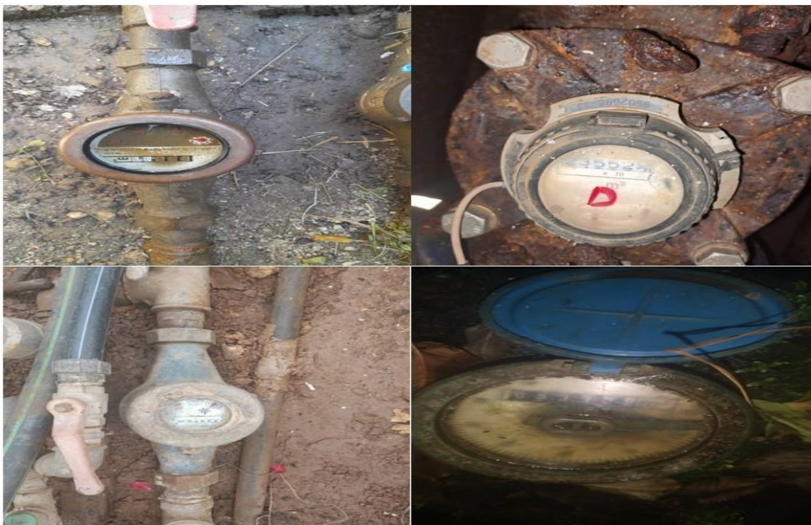
Slika br.22 Realan prikaz stanja mjernih mjesta i dotrajalosti vodomjera
