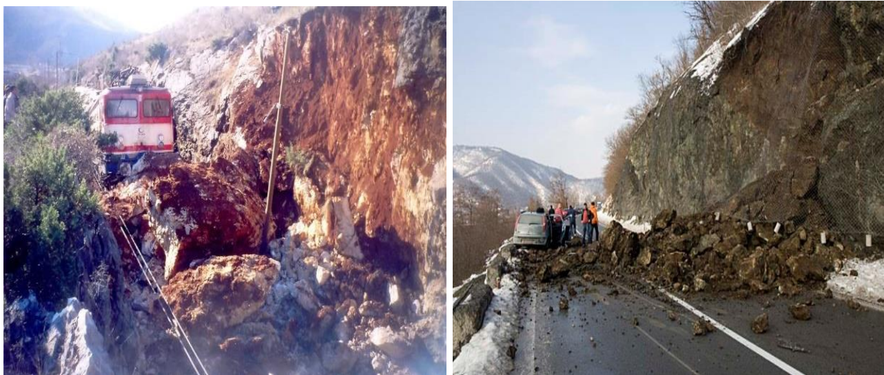
Slika 12: Česte pojave odrona u Crnoj Gori duž željezničke i putne infrastrukture
