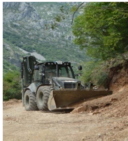
Detalji sa izgradnje puta selo Duga - selo Rijeka Piperska
