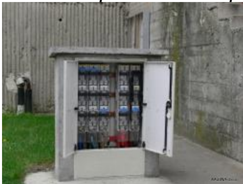
slika 17: izgled niskonaponskog razvodnog ormana sa 6 izvoda »NKRO6«
