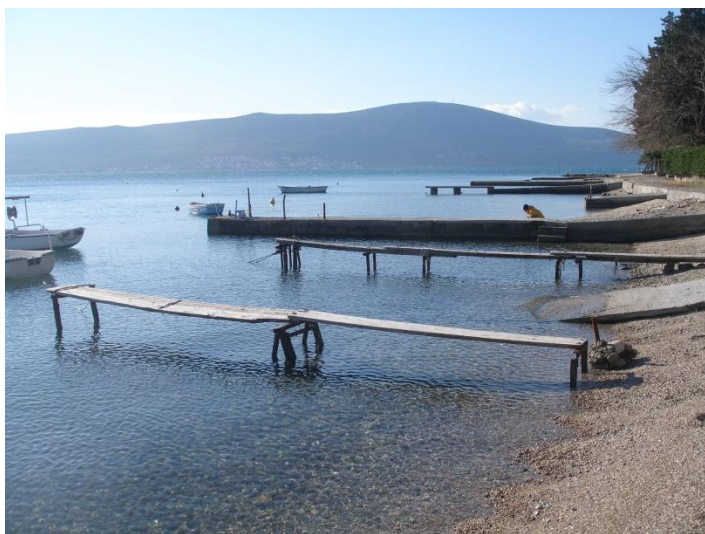
slika 10 : Postojeće drvene ponte na metalnoj konstrukciji
