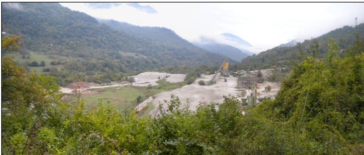
Слика бр. 22 Сепарација камена, фабрика бетона и асфалтна база предузећа „Хидроградња“
