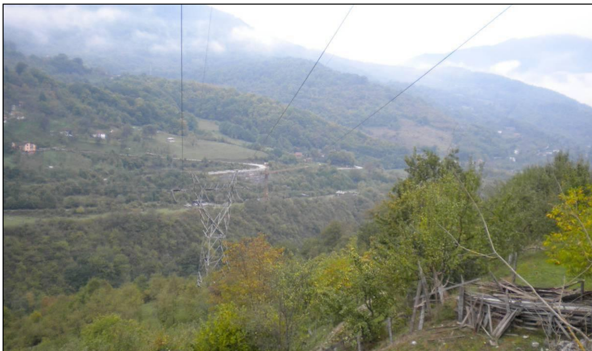
Слика бр. 21 400 kV далековод Сарајево – ХЕ Пива
