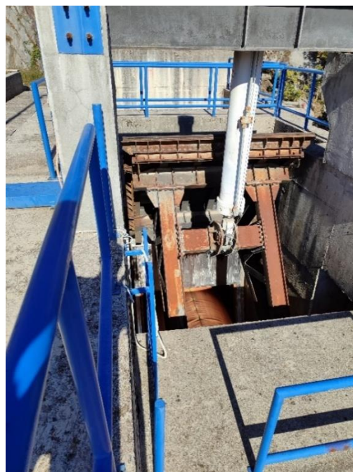
Slika 20. Segmentni regulacioni zatvarač na hidraulički pogon
