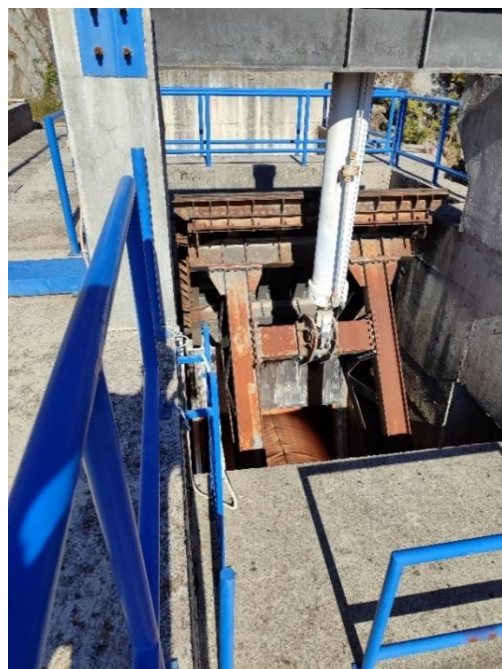
Slika 4. Segmentni regulacioni zatvarač na hidraulički pogon
