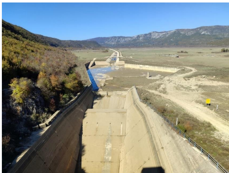
Slika 21. Kompezacioni bazen i ulazna građevina
