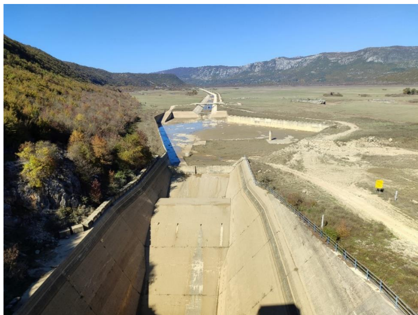
Slika 5. Kompezacioni bazen i ulazna građevina
