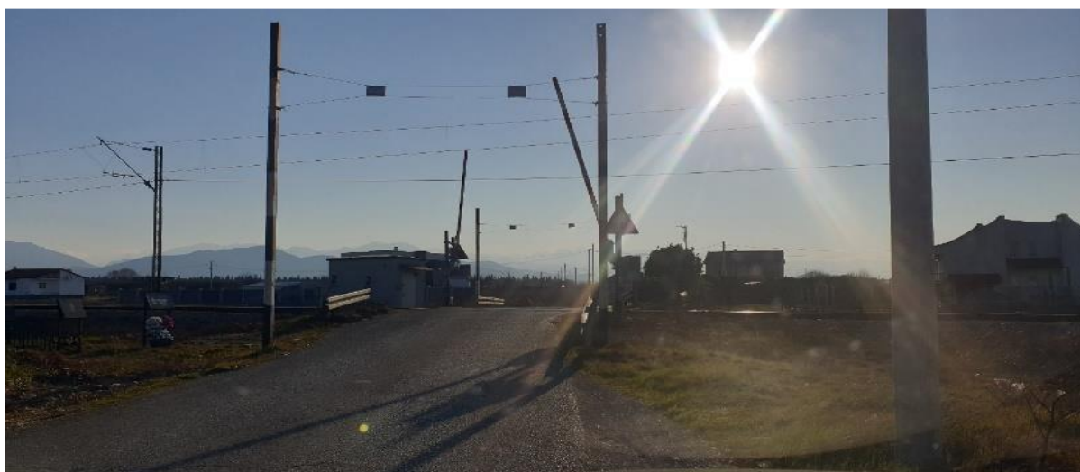
Slika 2: Željeznički prelaz Vukovci
