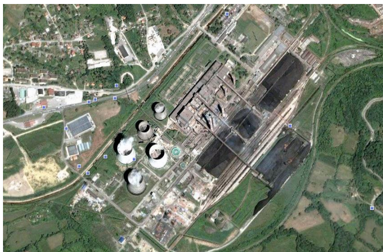
Slika 15. Lokacija TE Tuzla
