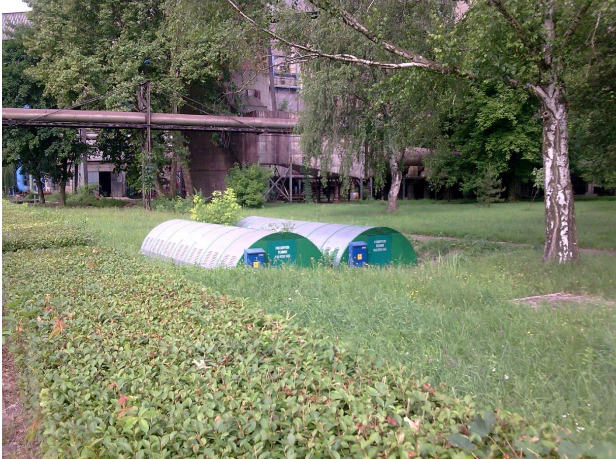
Slika 20. Tehnix biorotor, biološki prečištač otpadnih voda
