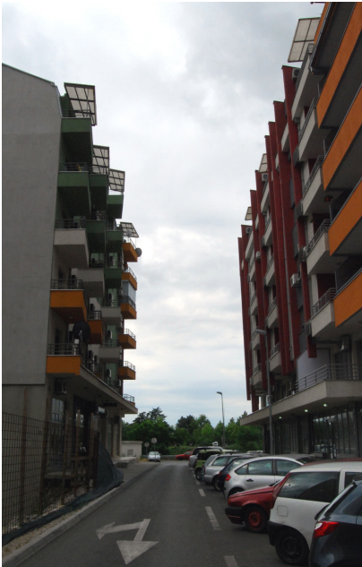
Loš primjer međusobnog rastojanja stambenih objekata, manje od 1H (blok preko puta Dječje bolnice, Podgorica)
