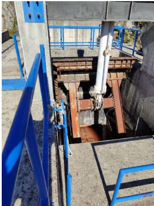
Слика 49. Сегментни регулациони затварач на хидраулички погон
