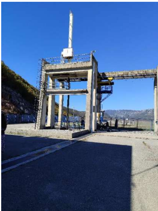
Слика 48. Табласти затварач на улазној грађевини
