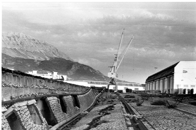
Slika 1.20-3 Luka Bar - kao jedan od najznačajnijih infrastrukturnih sistema Crne Gore, upravo je pred sam zemljotres bila dovršila i zaokružila izgradnju svoje druge razvojne faze. Nažalost mnogi njeni vitalni sadržaji pretpjeli su teška oštećenja. Na slici: sjeverni dio Gata br. 2 (Fotografija Svjetske banke).
