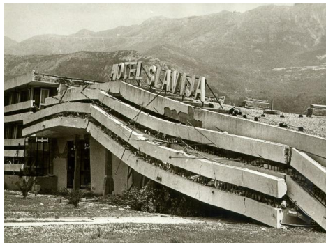
Slika 1.20-1 Hotel "Slavija" u Budvi, srušen u zemljotresu od 15. aprila 1979. kao primjer iz niza modernih hotela izgrađenih na poznatom kompleksu "Slovenska plaža", stradali u ovom zemljotresu.
