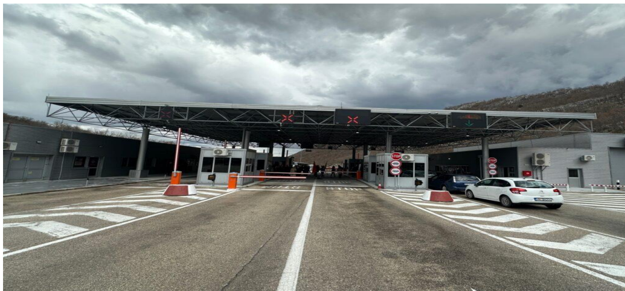
Novoizgrađeni Zajednički granični prelaz u Zupcima, na putnom pravcu Herceg Novi - Trebinje
