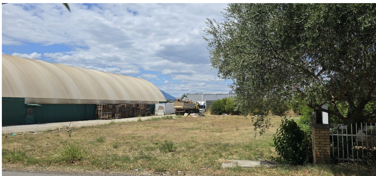
Sl.2. – Postojeće stanje
