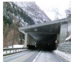
Zaštita od lavina betonskom galerijom
