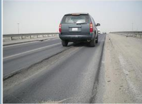
Debitna je pločnik usljed visoke temperature i propletanja.
