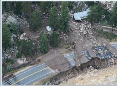
Put izručen tijekom erozije i labavljenja tla zbog izpoprečne doline
