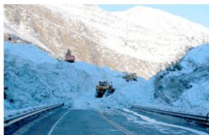
Lavina oštećuje i zatvara put
