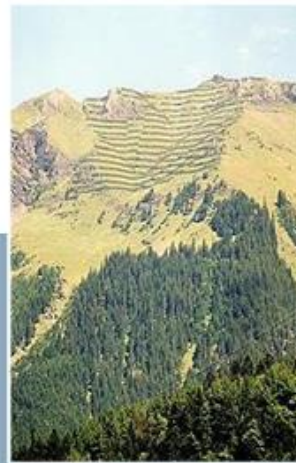
Šuma i strukture za zaštitu od lavina
