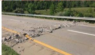
Toplo vrijeme dovodi do deformacije betona
