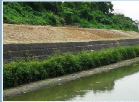
zagradnja međusobnih kanala i drenaža radi sprječavanja erozije voza
