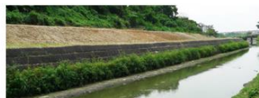
Izgradnja mrežastih kamenih zidova za sprječavanje vodene erozije
