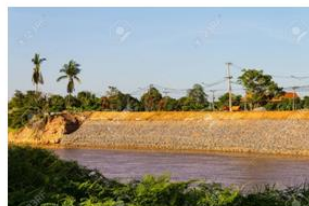
Izgradnja mrežastih kamenih zidova za sprječavanje vodene erozije
