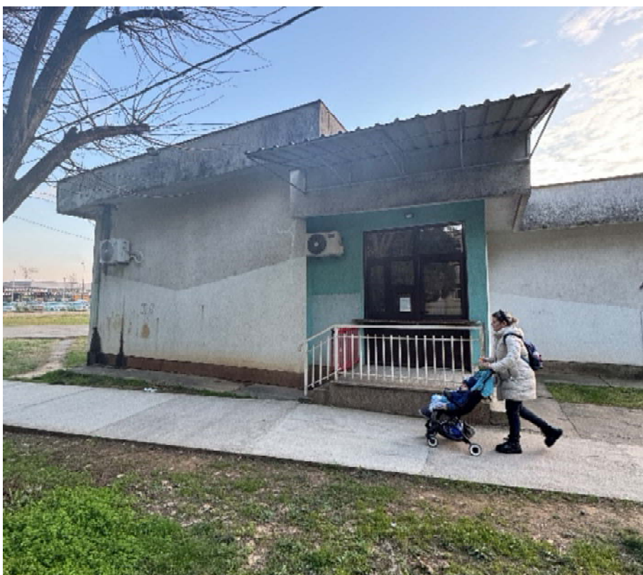
Fotografija 11 - Fasada objekta – nadogradnja nadstrešnice
