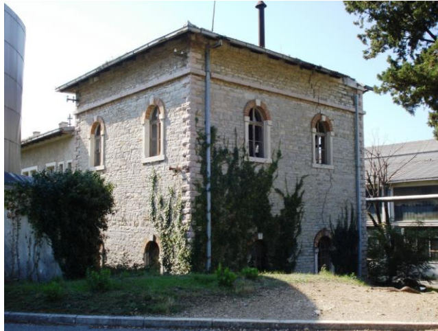
Slika 1.8. Vojno kupatilo - izgled objekta prije demontaže
