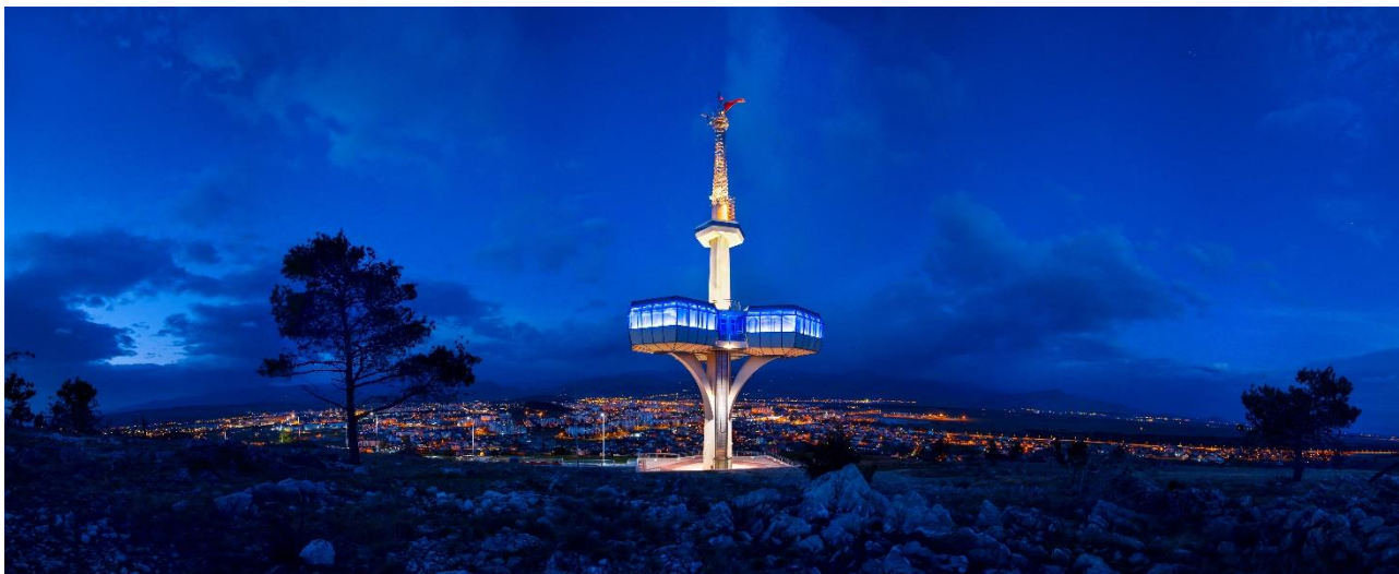
Glavni kontrolno-mjerni centar na Dajbabskoj gori u Podgorici
