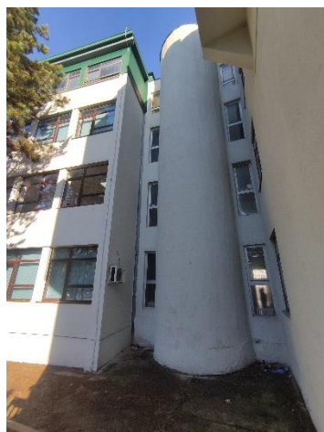
Fasada sa komunikacijama
