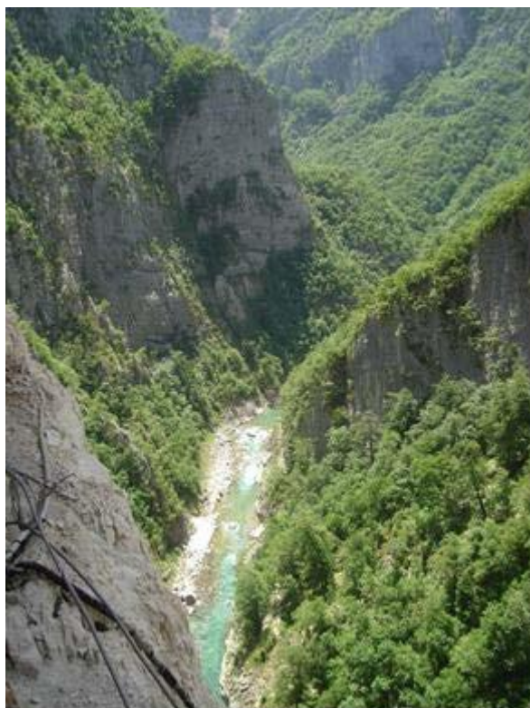
Slika 16. Kanjon uzvodno od brane
