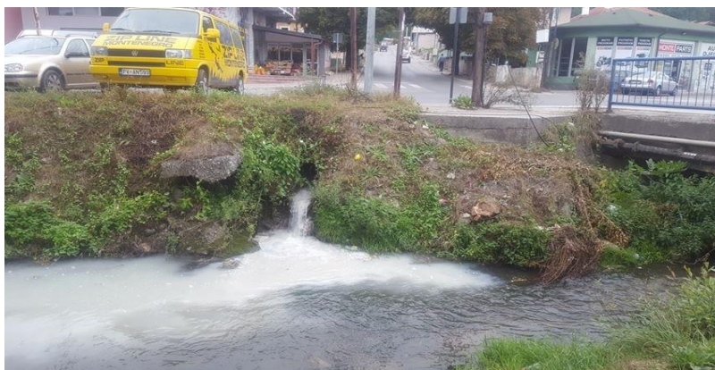
Slika 7.6. Pomješana atmosferska i fekalna kanalizacija u rijeci Breznici, mjesto Kameni most
