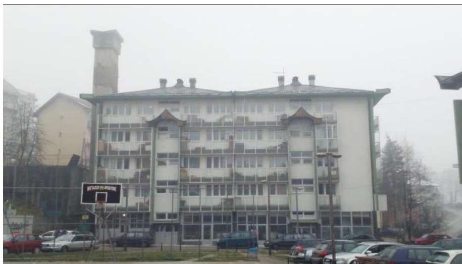
Slika 6.13. Zgrada u kojoj se nalaze kotlarnica i dimnjak
