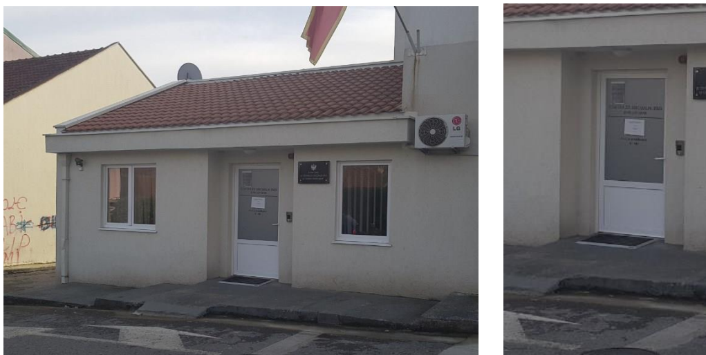
Slika 10. Objekat u Danilovgradu
