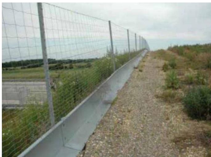
Slika 19: Ograda za gmizavce i krupne sisare
