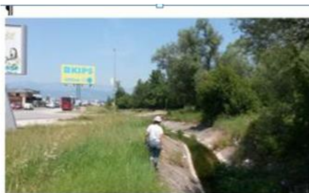
Slika 32. Drenažni kanali pored KIPS-a
