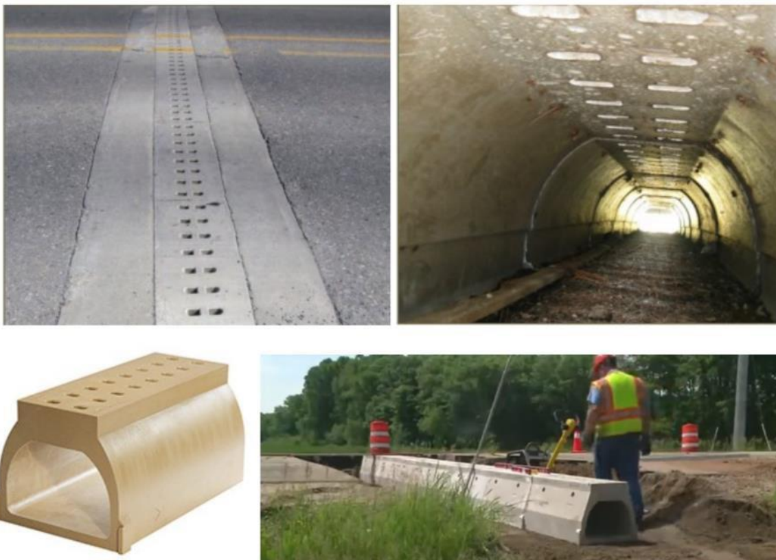
Slika 21: Mogući dizajn propusta za vodozemce, gmizavce i druge male životinje
