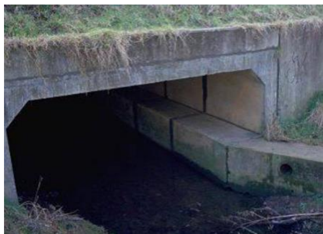
Slika 20: Pravougaoni propusti sa izbočinama za prolaz malih životinja
