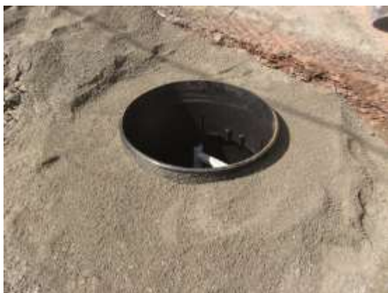
Slika 9 i 10: Postavljanje betonskog prstena za prihvata opterećenja
