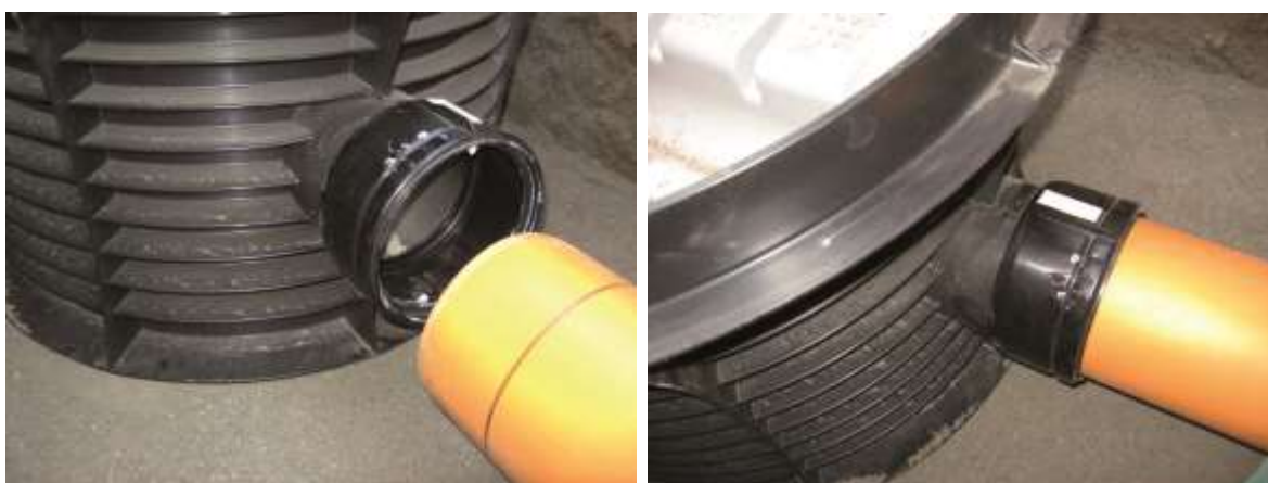
Slika 5 i 6: Izvođenje spoja šahta sa PVC cijevima
