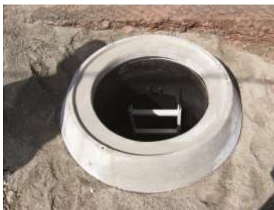
Slika 9 i 10: Postavljanje betonskog prstena za prihvata opterećenja
