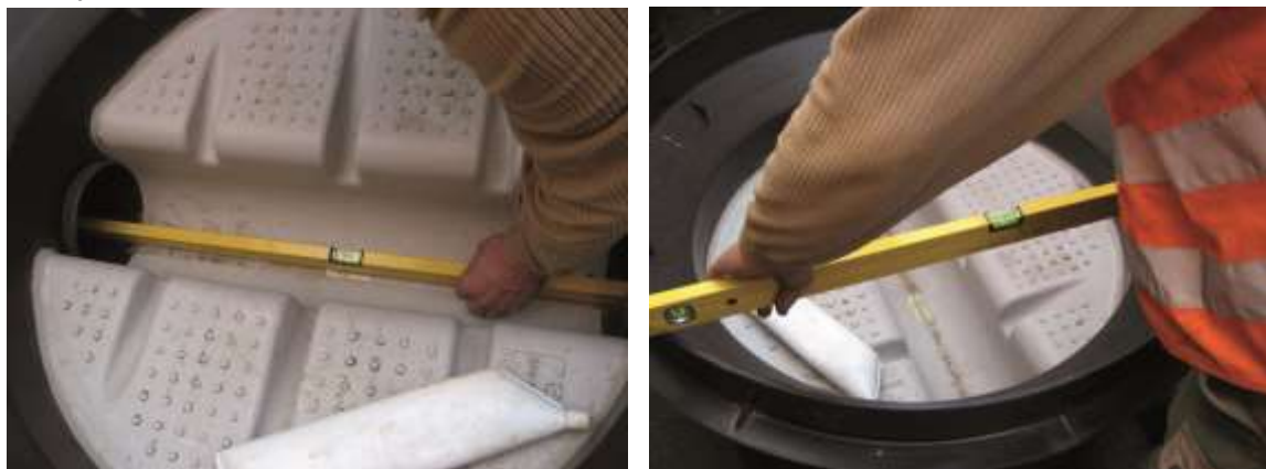
Slika 3 i 4: Kontrola položaja odvoda
