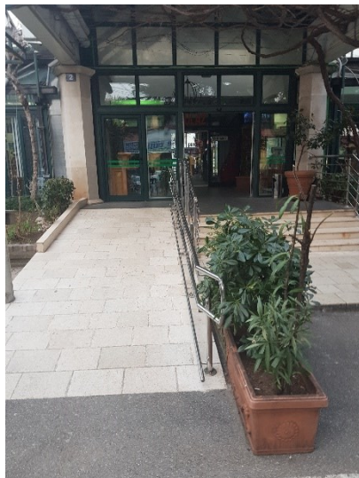
Slika 1.1. Glavni ulaz na autobusku stanicu
