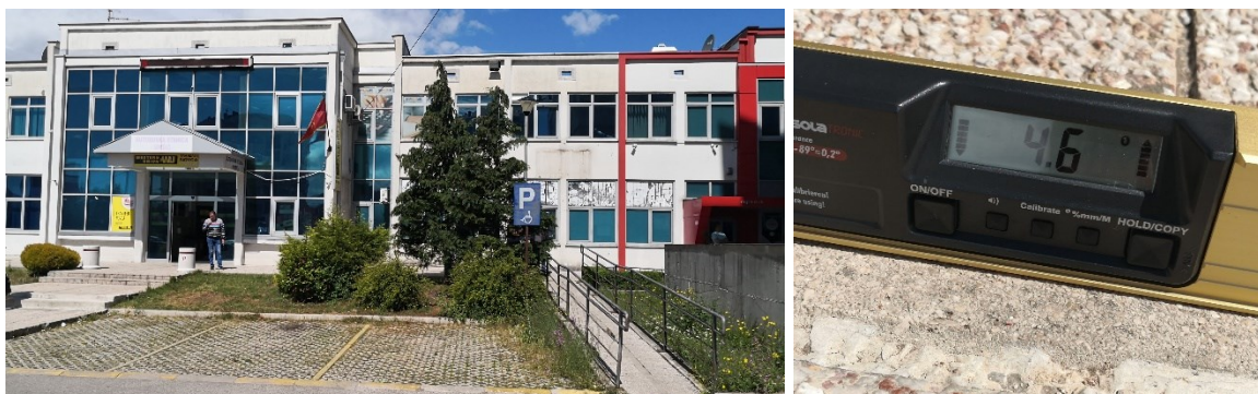
Slika 9.2. Pristup zgradi autobuske stanice sa parking mjestima za lica smanjene pokretljivosti i lica sa invaliditetom sa uzdužnim nagibom rampe
