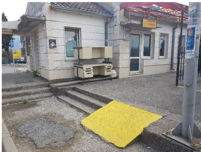
Slika 6.1. Izgled pristupa sa javne pješačke površine i glavnog puta
