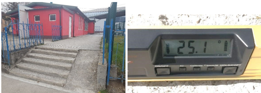
Slika 12.3. Ulaz sa javne pješačke površine i nagib rampe za ulazak lica smanjene pokretljivosti i lica sa invaliditetom
