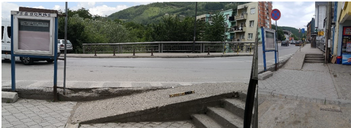
Slika 3.1. Ulaz na autobusku stanicu sa javne pješačke površine i glavnog puta
