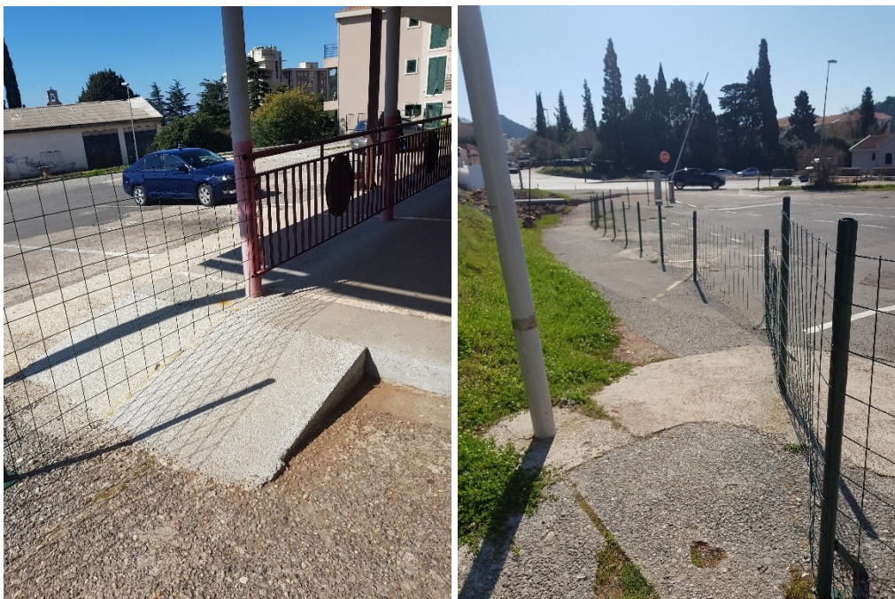
Slika 10.1. Otvoreni ulaz i pristup objektu autobuske stanice
