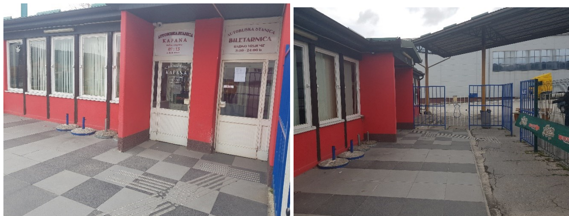
Slika 12.1. Ulaz u objekat autobuske stanice i pješački prolaz
