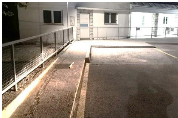
Slika 5.3. Prilaz peronima za prijem i otpremu putnika lica smanjene pokretljivosti i lica sa invaliditetom
