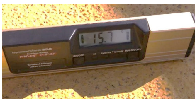
Slika 6.2. Uzdužni nagib rampe za ulazak na autobusku stanicu
