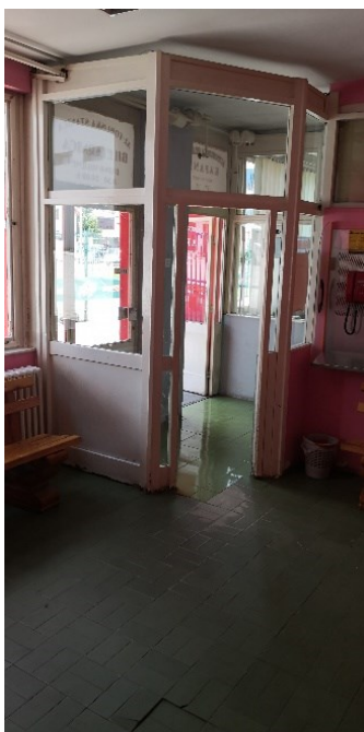
Slika 12.2. Hodnici unutar objekta
