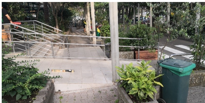
Slika 1.3. Ulaz na autobusku stanica posjeduje rampu da uzdužnim uglom 7,4 °
