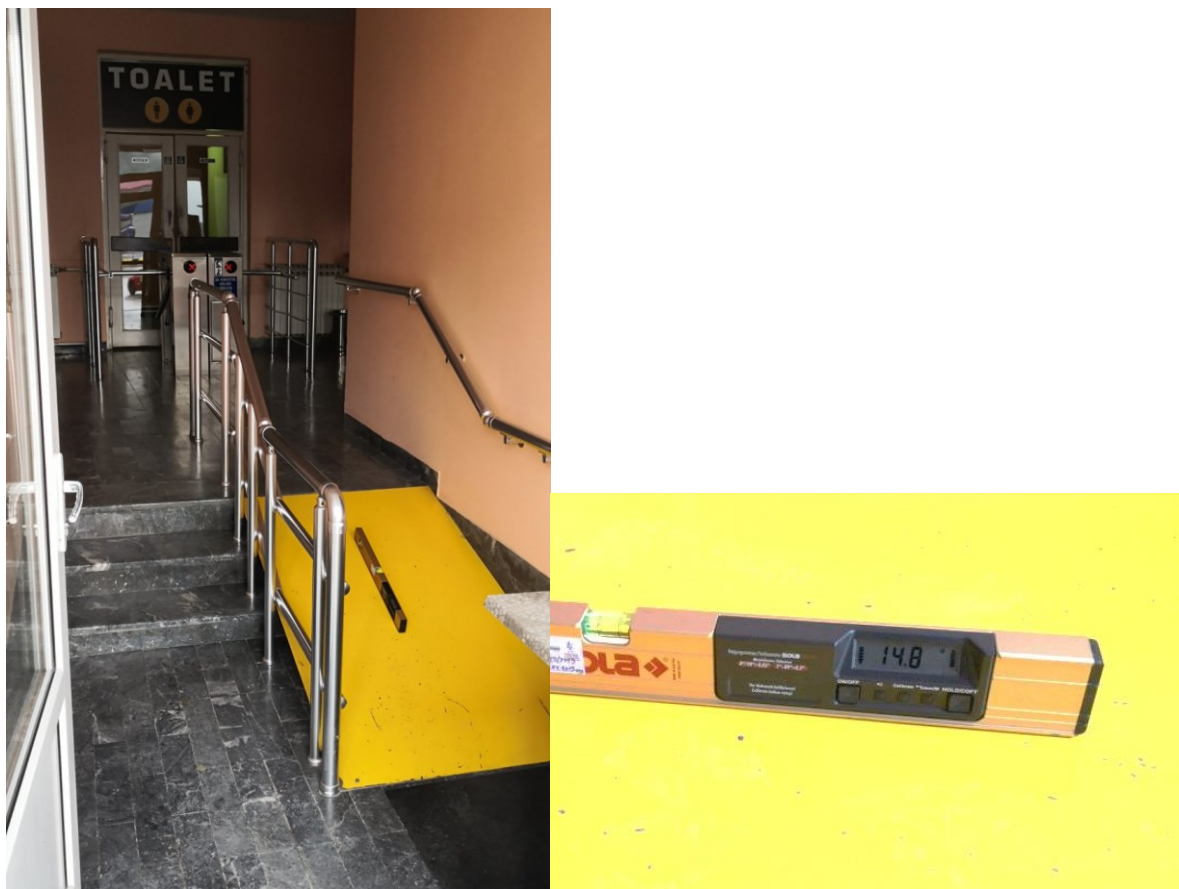
Slika 15.3. Ulaz u zgradu autobuske stanice i uzdužni nagib ulazne rampe
